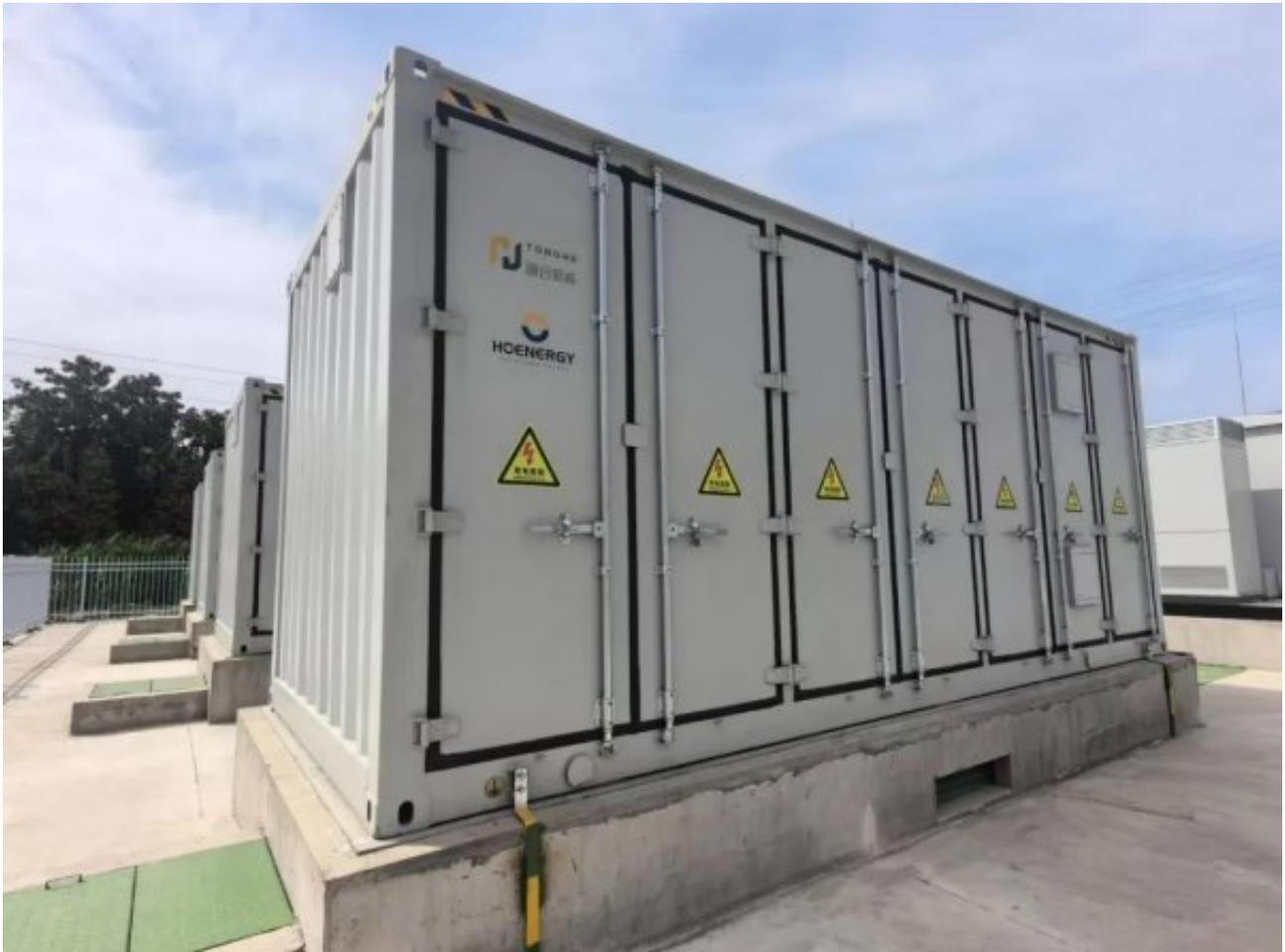
新申达项目采用“4台弘正储能D-Ocean 5.0 16MWh液冷直流舱+4台逆变升压一体舱”的核心配置，通过10kV高压并网接入厂区电网，并设置防逆流装置，在严守并网规范的同时，阻断电力倒灌风险，全方位保障厂区电网安全。
